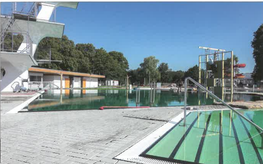
■ ... das neue Funktionsgebäude (links) an den umgebauten Wasserflächen ...
