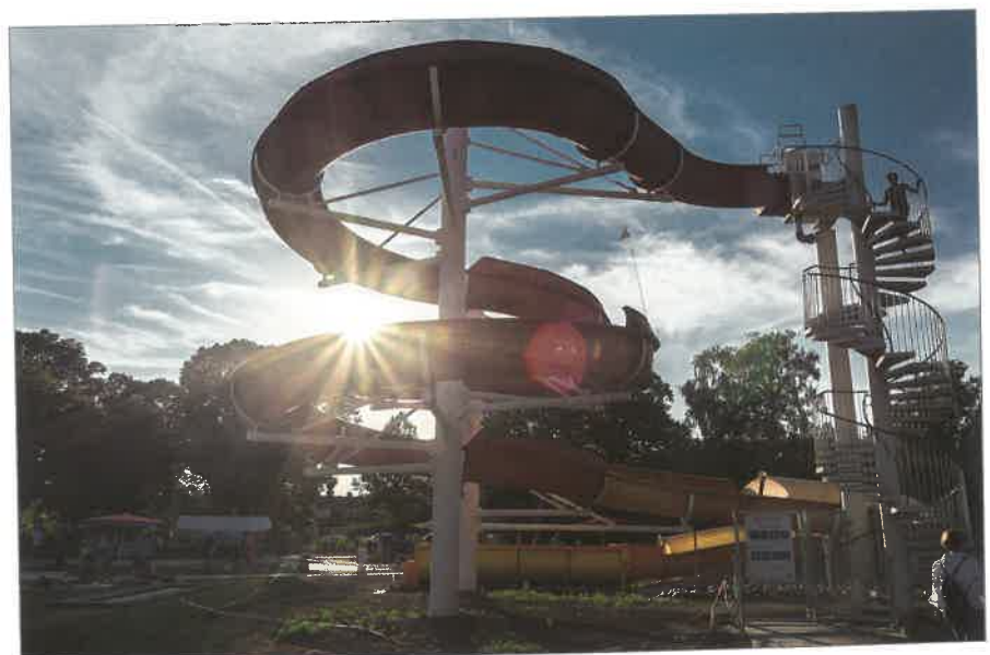
■ Die wiederverwendete Rutsche mit neuem Auffangkissen
