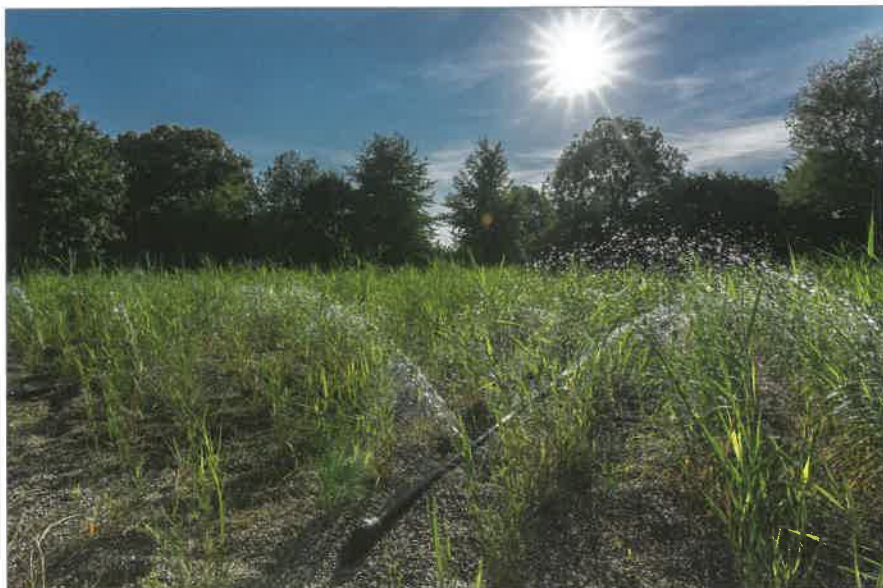
■ Rohwasserverbreitung auf dem Geomatrix®-Bodenfilter
